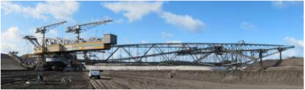
500 m von der Baggerseite bis zur Abraumhalde, auf Schienen beweglich
